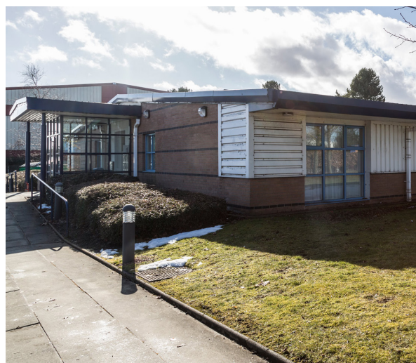
La struttura di Apex a Loanhead
