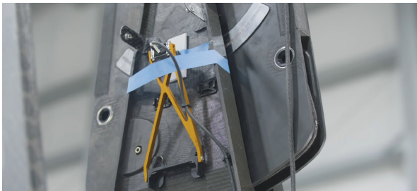
Encoder installati sulla piastra di controllo dei flap
