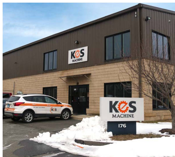
Installation de KES Machine dans le Connecticut, aux États-Unis
