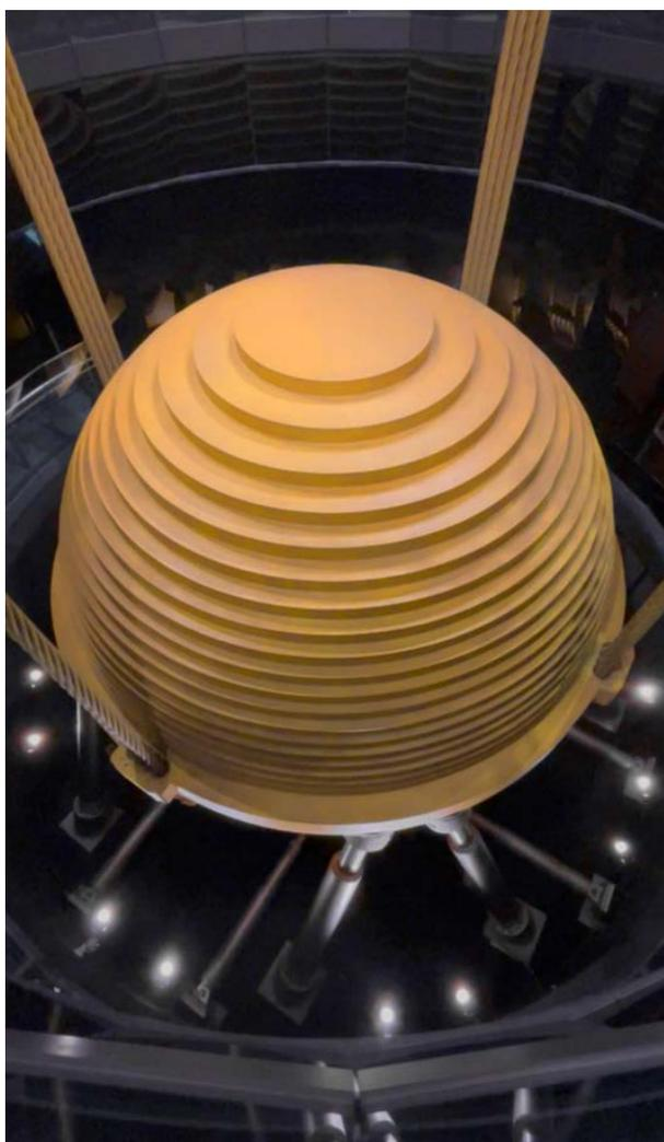
图3: 中国台北101大楼上的TMD系统
