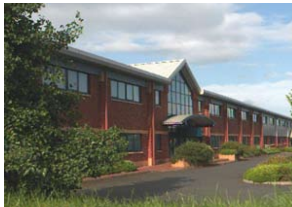
Fabryka Stonehouse – widok z przodu.
