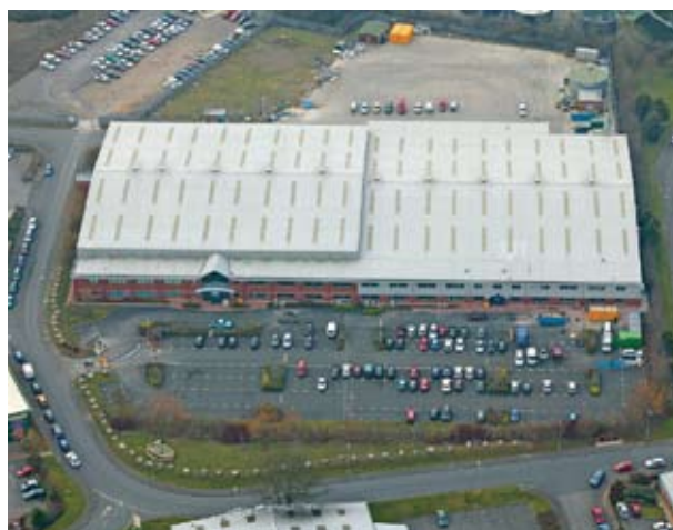
Fabryka Stonehouse – widok z powietrza.
